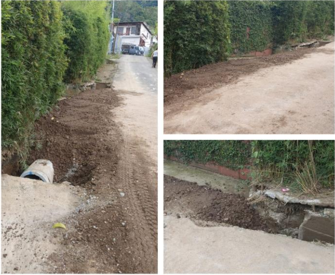
Cambio de tubería y conformación de calle en Pueblo Escondido
