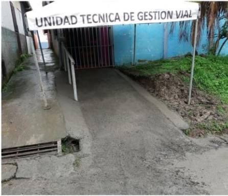
Construcción de rampas en Urbanización La Guápil para dar acceso a personas con discapacidad de acuerdo a la Ley 7600.
