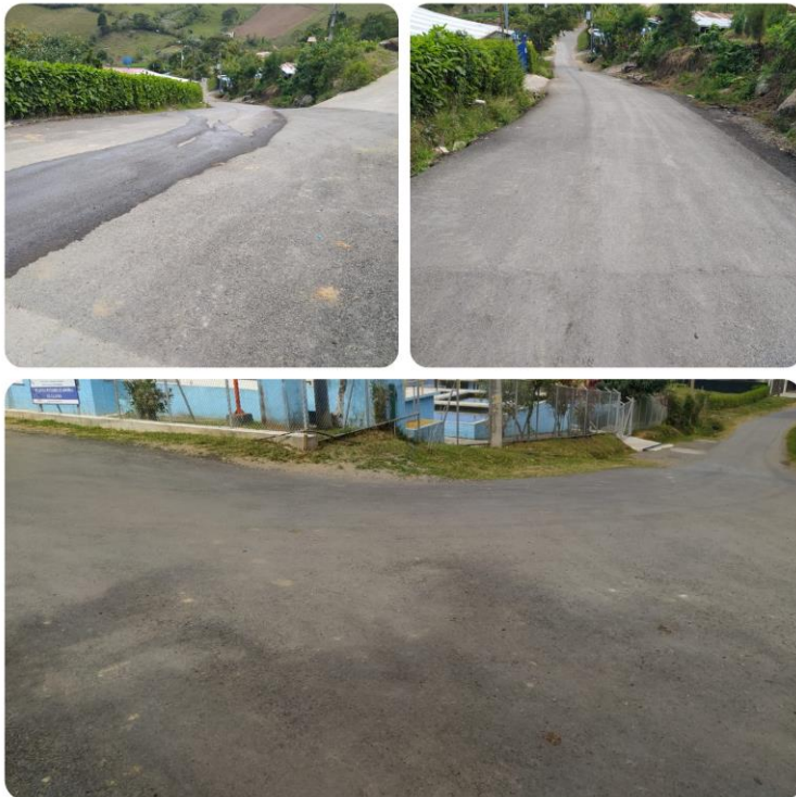
Sector de los tanques en San Antonio
